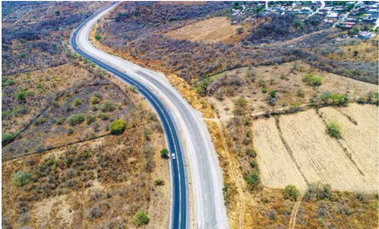
Figura 1. Vista aérea de la carretera Siglo XXI, en donde se aprecia la magnitud de la obra de ampliación en términos de superficie de selva baja caducifolia. Foto: Xavier López Medellín.
