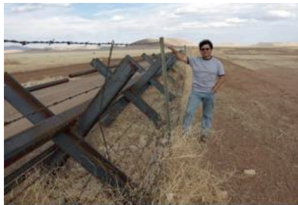
Figura 17. Barreras de Normandía y cerco de púas en el cruce internacional “El Berrendo”, en la frontera entre Janos, Chihuahua e Hidalgo, Nuevo Mexico (Foto: Rurik List).
