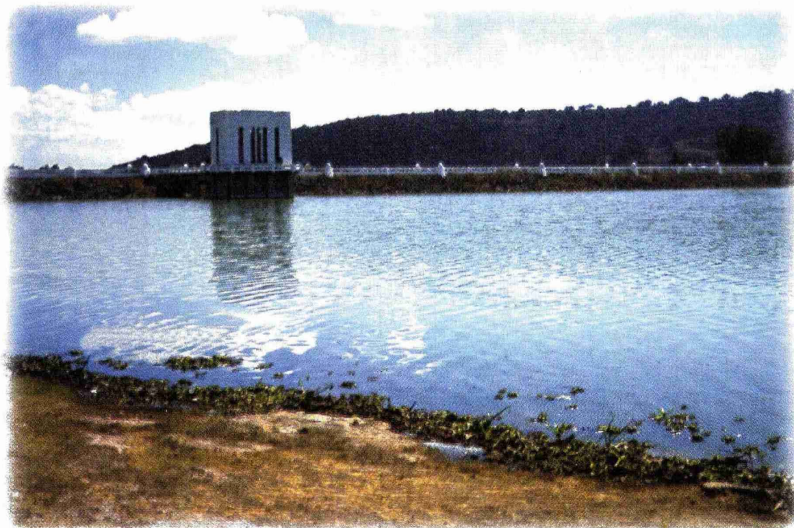
Una vista de la cortina de la presa Manuel Ávila Camacho.
