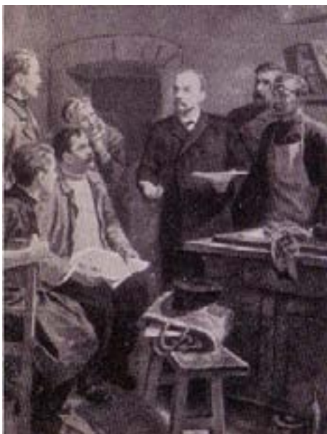
Lenin difundiendo el marxismo entre los obreros
