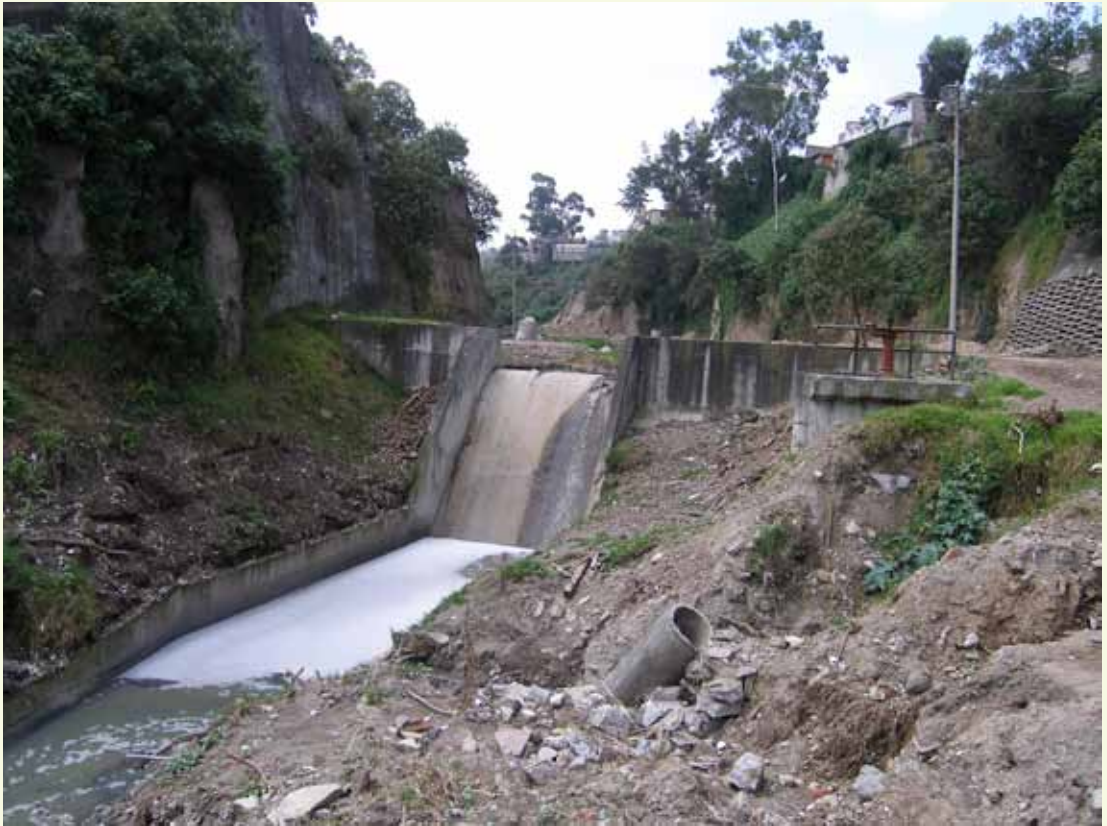
Figura 6. Presa reguladora de avenidas ubicada en la parte media de la barranca. Foto: Equipo multidisciplinario de la UNAM del proyecto "Propuesta de rescate ambiental integral de la barranca del río San Borja".
